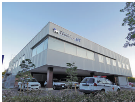
メディカルプラザの2階には、健康増進センターACTが入る予定である。
